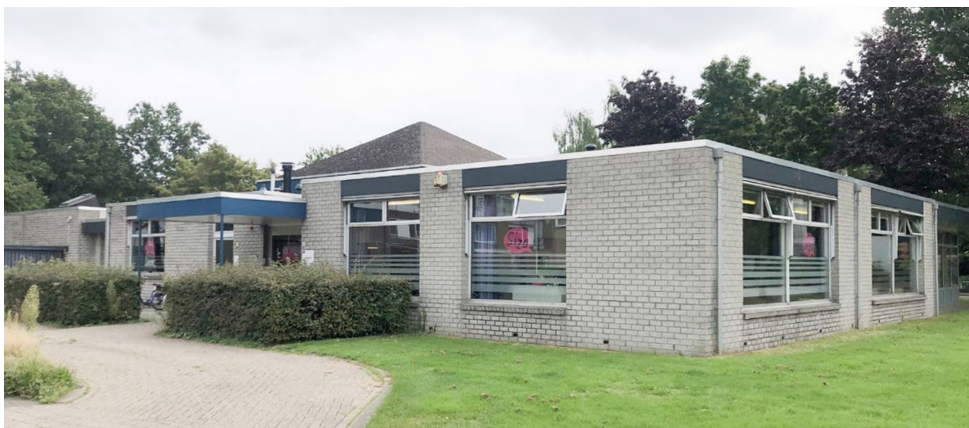
Huidige bebouwing Karmijnstraat 5
